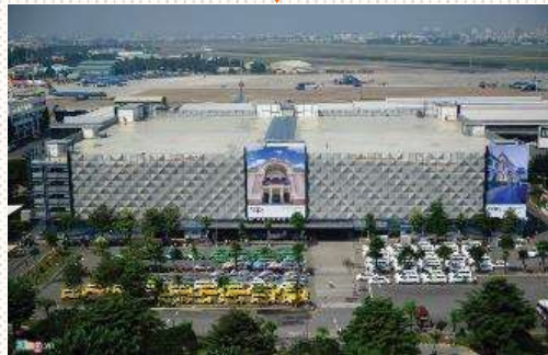
THE 5-STOREY CAR PARK TAN SON NHAT AIRPORT NHÀ XE SÂN BAY TÂN SƠN NHẤT - 5 TẦNG
